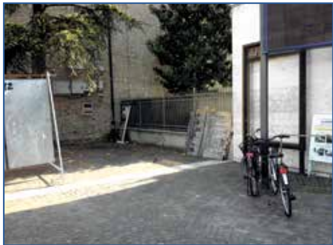
Ecco sopra come appare l'angolo di piazza Giovanni XXIII verso il Duomo. A parte i pannelli dei quadri elettrici non proprio decorativi, lì si sta accumulando sporcizia di ogni genere
