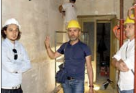
Il sopralluogo al Bottagisio
