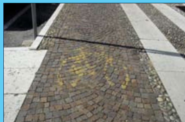
Le indicazioni orizzontali indicanti che lo spazio definito con il porfido è riservato alle biciclette
